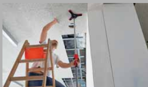
Tripé de construção STE-BS
